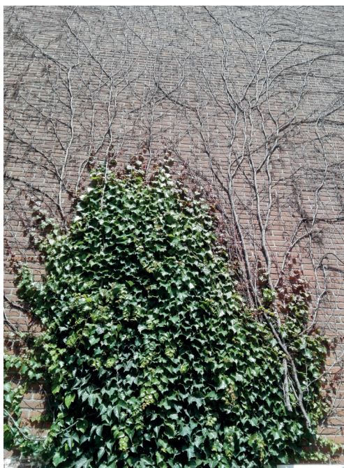
Façade latérale de l'immeuble de Soraya (juillet 2020)
